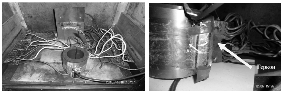
Рис. 13 – Внешний вид испытательной камеры с установленным в ней экспериментальным соленоидом и герконом
