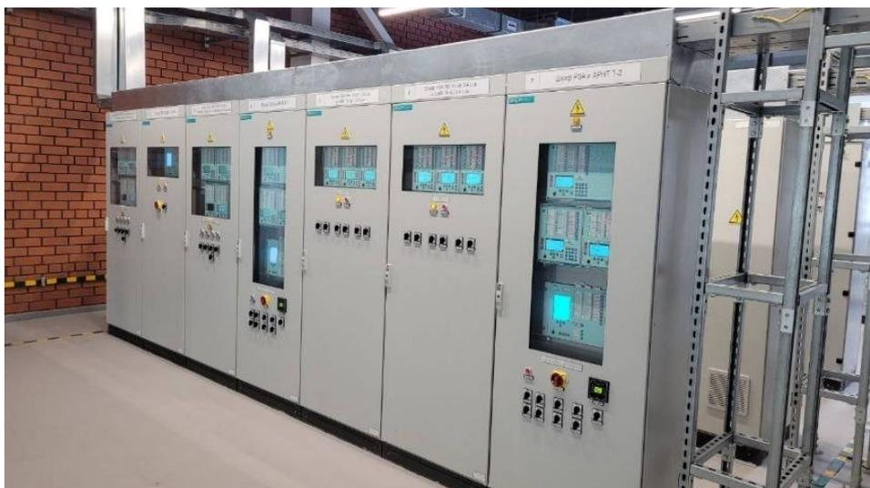
Рис. 4. Общеподстанционный пункт управления цифровой подстанцией «Развитие» 110/10/10 кВ
